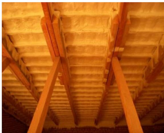
*Рис. 9. Теплый чердак с пенополиуретаном в жилом доме*
